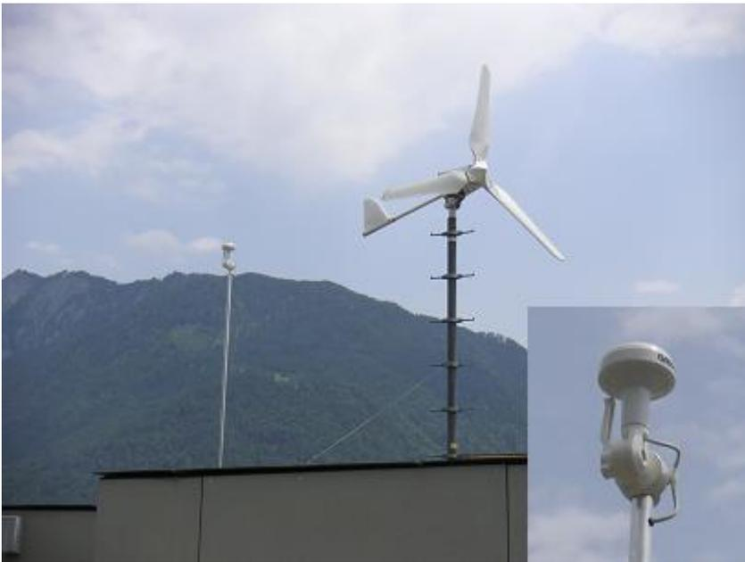
Abbildung 6: GPS-Antenne auf dem Dach der HTW Chur
